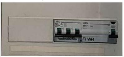
• nach mindestens 2 Minuten in umgekehrter Reihenfolge wieder zu schalten (Sicherungen - >Solardrehschalten->Batterietrennschalter->Der SE startet automatisch neu
