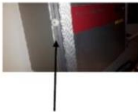
DC Trennschalter im Gehäuse
